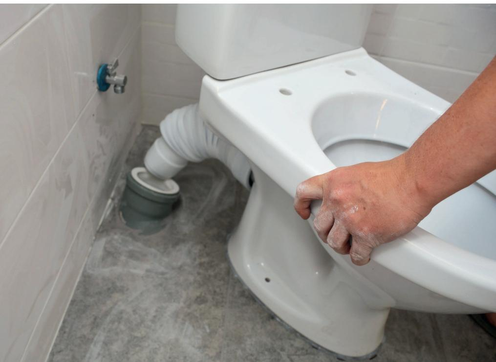
*Un buen sellado empieza por una superficie limpia y seca. El anillo debe colocarse centrado y sin aplastar antes de que la taza se fije.*
