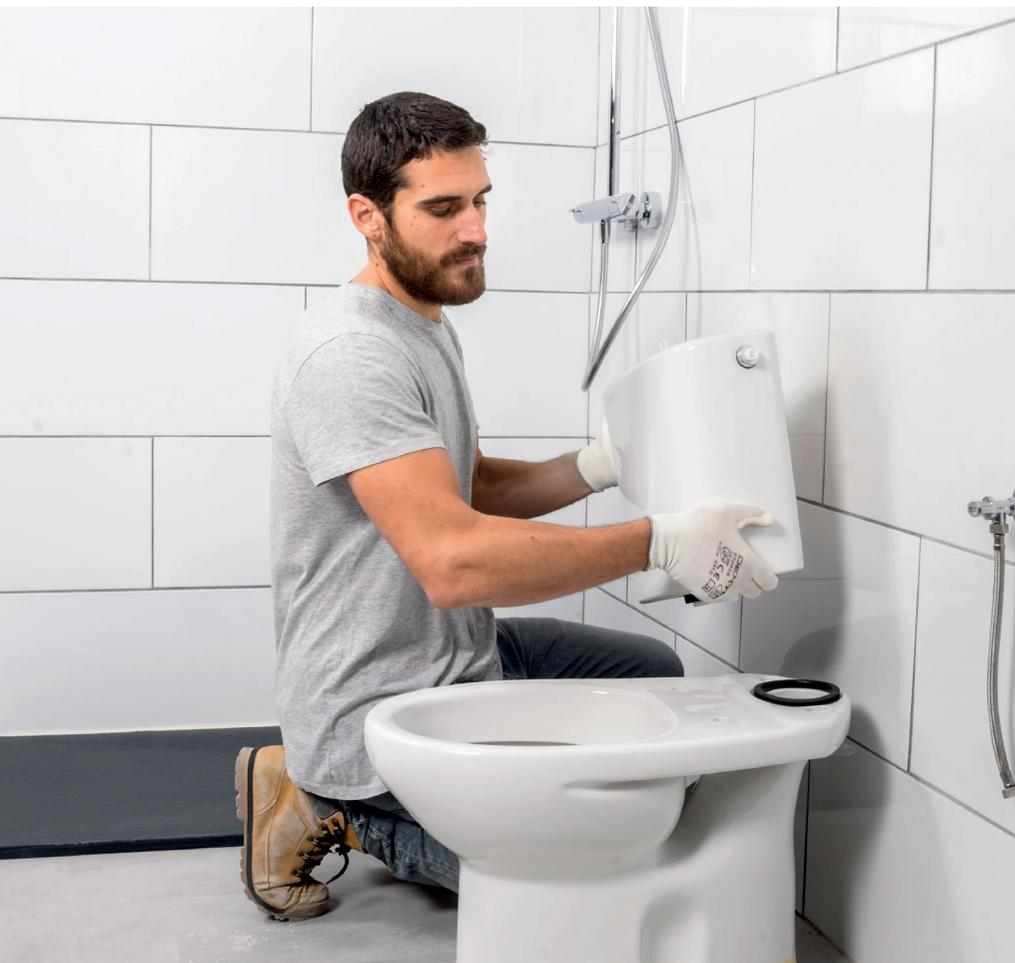
*Los tornillos de fijación del WC hacen más que mantenerlo en su lugar: aseguran la presión constante sobre el sello de cera, evitando fugas.*
