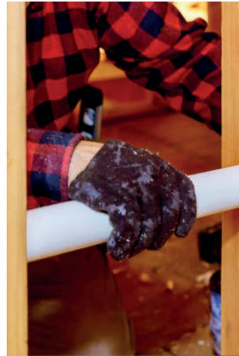
*En el caso de los cementos disolventes, la unión contempla el uso de solventes selectivos que empiezan por reblandecer la pared de la tubería, para en seguida generar una unión química unificada a través de la coalescencia de materiales.*
