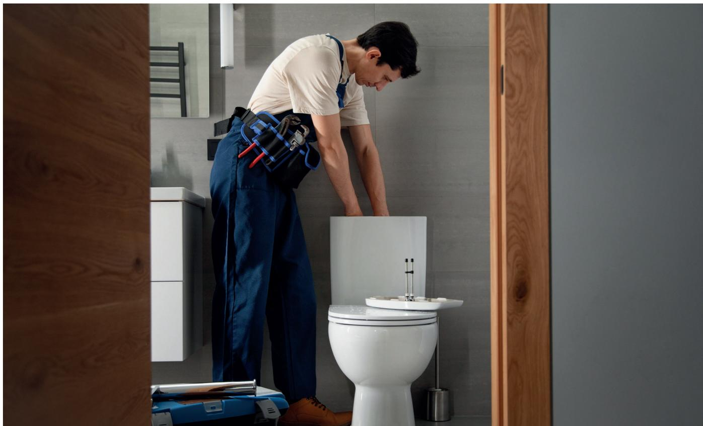
flojos o piezas mal calibradas. Revisar con agua a presión y observar al menos dos ciclos de llenado y descarga es la mejor garantía contra reclamos y retrabajos.
