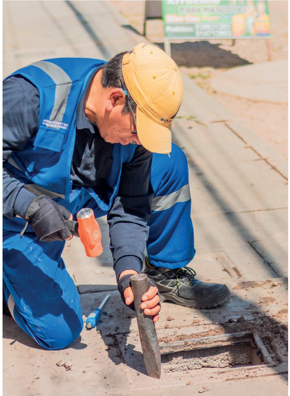
que permita conectar las tuberías de entrada y salida con la pendiente adecuada (mínimo de 1 a 2%) para asegurar el flujo por gravedad. El registro debe tener una base de concreto o mampostería, con las canaletas de flujo bien definidas, y una tapa hermética, pero removible, que evite el escape de malos olores y el ingreso de residuos, pero que permita el acceso rápido para mantenimiento.
