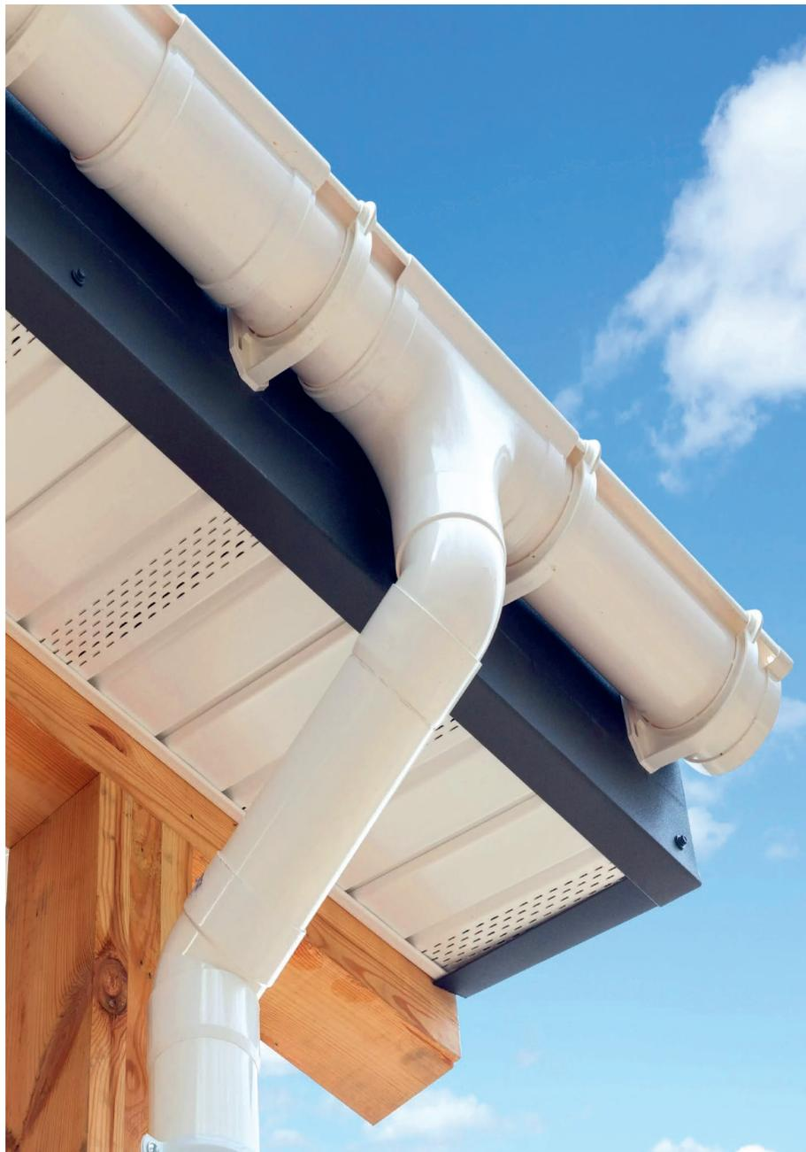
La instalación de las bajantes requiere precisión. Deben colocarse en los puntos más bajos de la azotea y conectarse a las canaletas de manera hermética. Es crucial asegurar que las bajantes queden separadas de la pared de la edificación, generalmente mediante abrazaderas o soportes, para evitar que la humedad afecte la fachada. Además, el tramo final de la bajante debe dirigir el agua lejos de la cimentación de la casa para prevenir daños estructurales.
