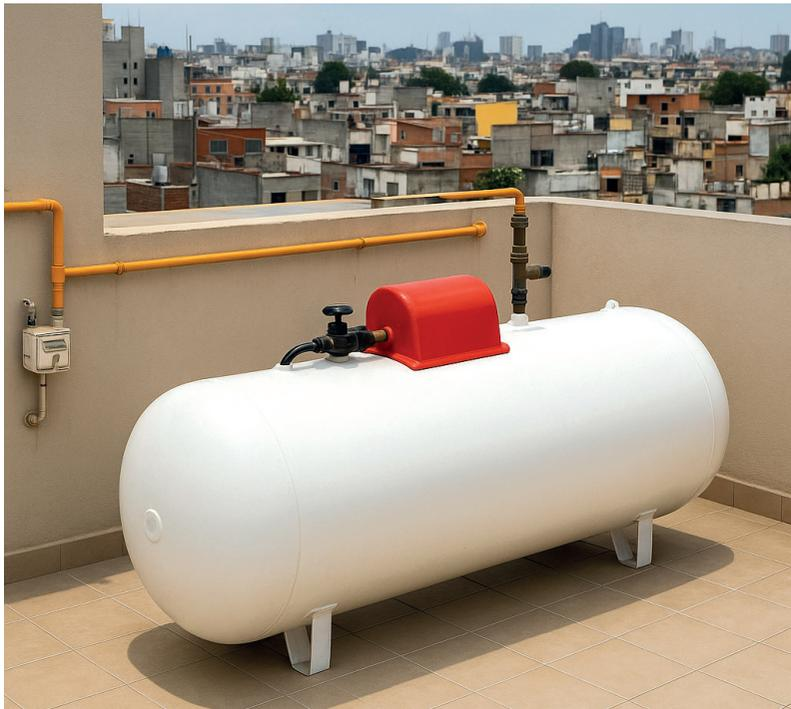
Los recipientes no portátiles deben cumplir con normas oficiales, contar con placa de identificación legible y estar debidamente soportados sobre bases diseñadas para resistir su peso lleno.
