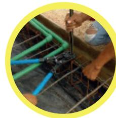
Una vez punchadas las conexiones pueden girar sobre su propio eje 360°
